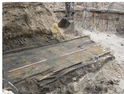
Afb. 3.08 Houtenfundering onder de baksteenconstructie, rechts een detail van de opstaande rand.
